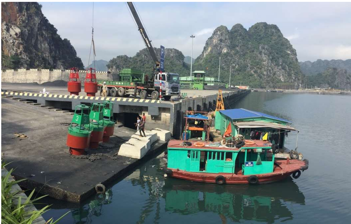
Lắp đặt hệ thống phao báo hiệu hàng hải tuyến luồng cảng 324 – Cẩm Phả, Quảng Ninh Buoy navigation installation at Channel 324-Cam Pha, Quang Ninh
