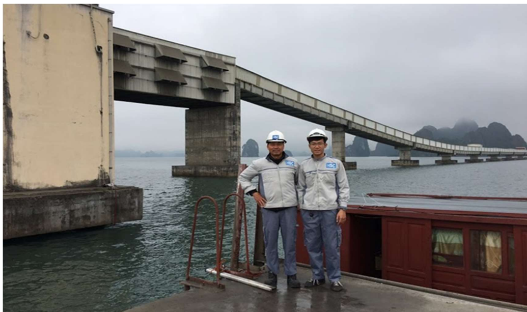
Khảo sát vùng nước trước bến và tuyến luồng Nhà máy Xi măng Cẩm Phả - Quảng Ninh/ Surveying work at Jetty and channel at Cam Pha Cement Grinding Plant, Quang Ninh
