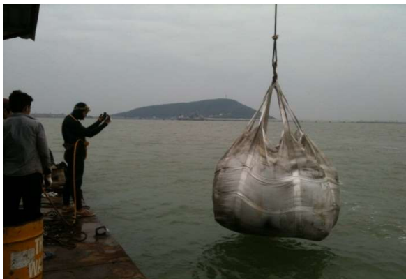
Lắp đặt lưới chắn bùn tại Nhà máy Lọc hóa dầu Nghi Sơn – Thanh Hóa Silt curtain installing at Nghi Son Refinery and Petrochemical Limited Liability Company-Thanh Hoa
