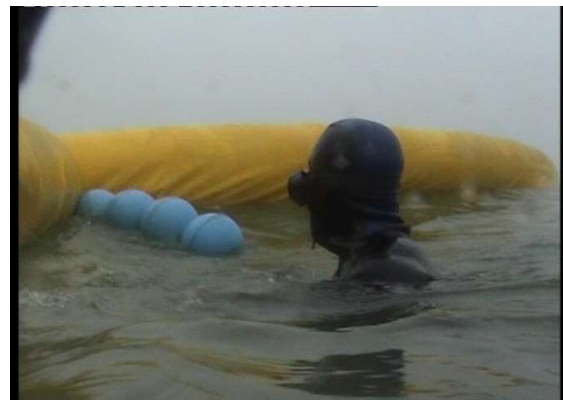
Lắp đặt lưới chắn bùn tại Nhà máy Lọc hóa dầu Nghi Sơn – Thanh Hóa Silt curtain installing at Nghi Son Refinery and Petrochemical Limited Liability Company-Thanh Hoa
